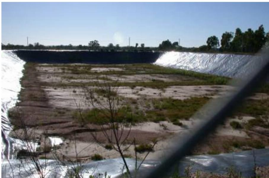
Los SDF de Usina 8 (Felipe Cardoso) y Rincón de la Bolsa, son los únicos que disponen de cobertura artificial inferior impermeable, en la base del vertedero, la cual se compone por una membrana de PVC de 0,8 mm de espesor para Felipe Cardoso y de 2,0 milímetros para Rincón de la Bolsa. La geomembrana está dispuesta sobre el subsuelo y está protegida por una capa de suelos propios del lugar, de 30 cm de espesor.
